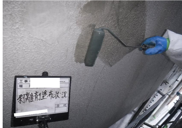
①剥離剤を塗布し、十分に浸透させ塗料材をはくりする。
