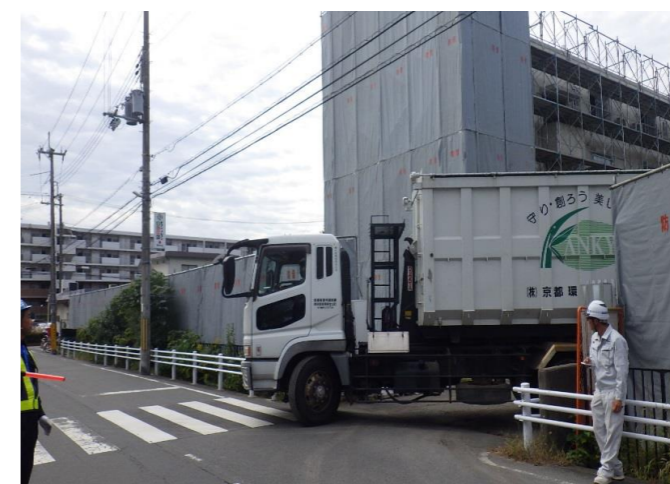
⑨袋詰めにした石綿を専用車両にて処分地へ運搬し埋立処分を行う
