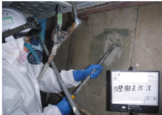
②塗料材が剥離した状態でスクレーパーにて削り落とし除去を行う
