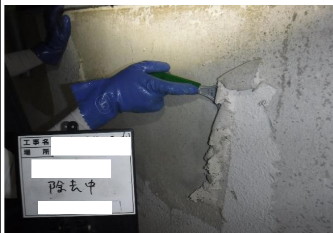
③壁面の塗料を地まで削り、除去残しの無い様ケレンする。
