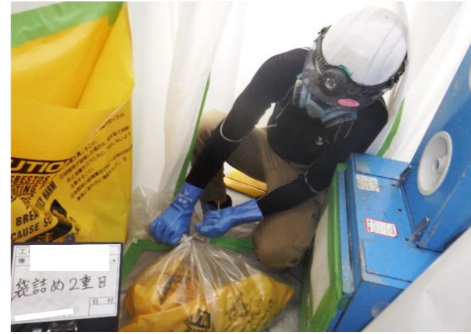
④除去した石綿含有物を専用の袋に2重詰めにする。
