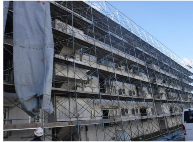
・作業用足場の組立状況
