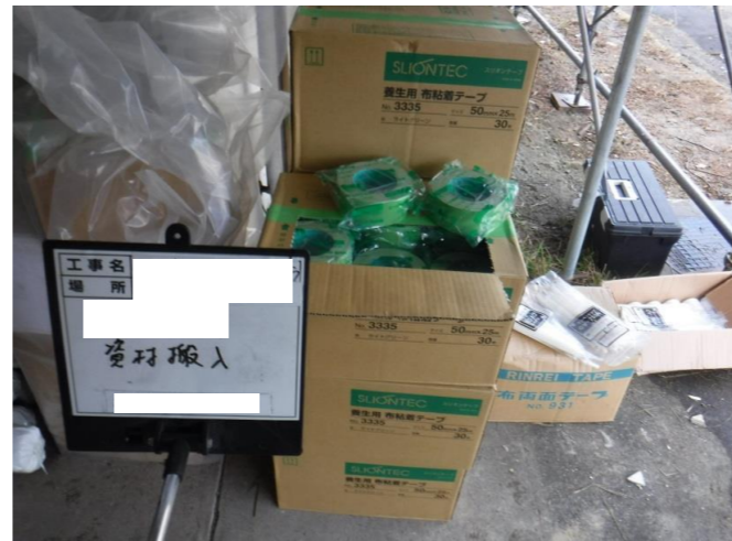
・資機材類(養生用テープ)
