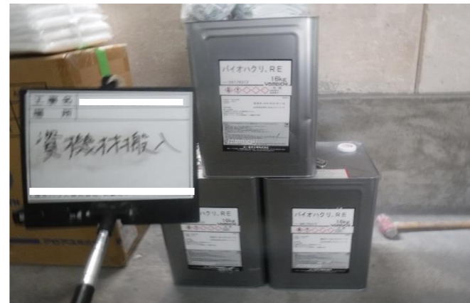
・資機材類(剥離剤/飛散防止剤)
