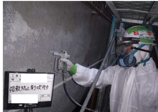
⑤除去した壁面に飛散防止材を吹付け目に見えない粉じんを固着する。
