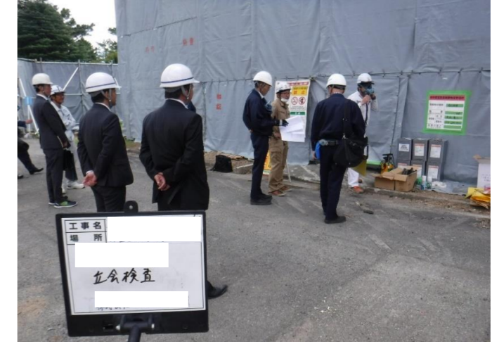
・諸官庁立会検査状況
